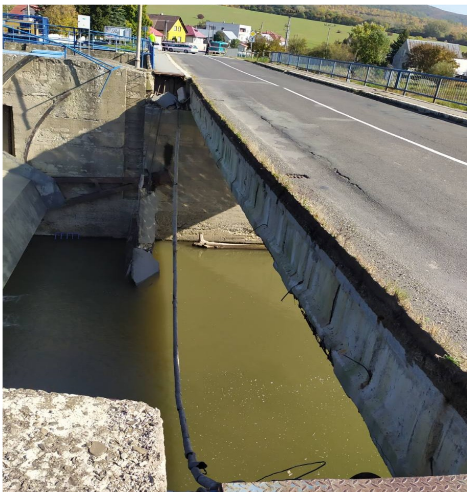
Fotografia 2 dňa 14.10.2019 došlo k zrúteniu krajného nosníka, na ktorom bol chodník
